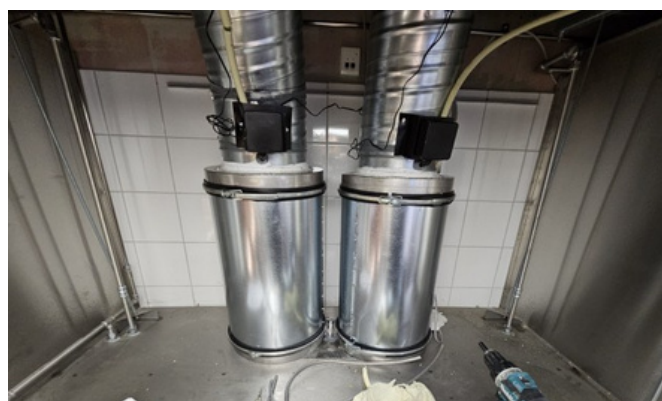
Två Lynx-enheter med monterade styrboxar och klämringar, klara för drift.
