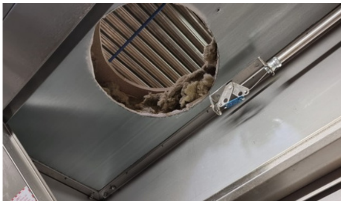
360 mm öppning utskuren i kökskåpens toppskiva.
