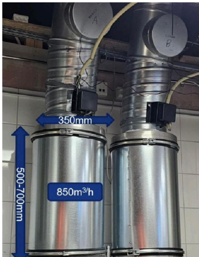
Två Lynx Kitchen-enheter monterade ovanför en kökskåpa. Mått: 350 mm i diameter, 500–700 mm höjd och en kapacitet på 850 m 3 /h per enhet.
