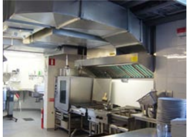
Köket i en sportbar, där avluften släpps ut i fasaden
